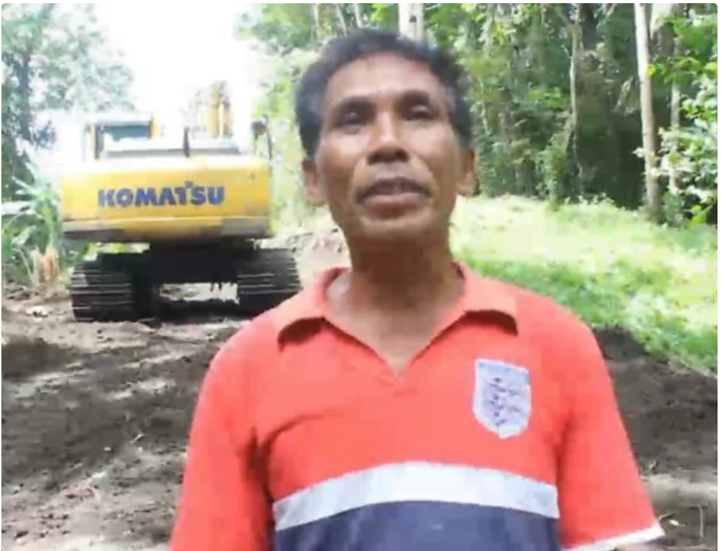
Galvi Karaki, Pemilik Lahan Lokasi Pembukaan Jalan TMMD Ke 116 Kodim 1310 Bitung
