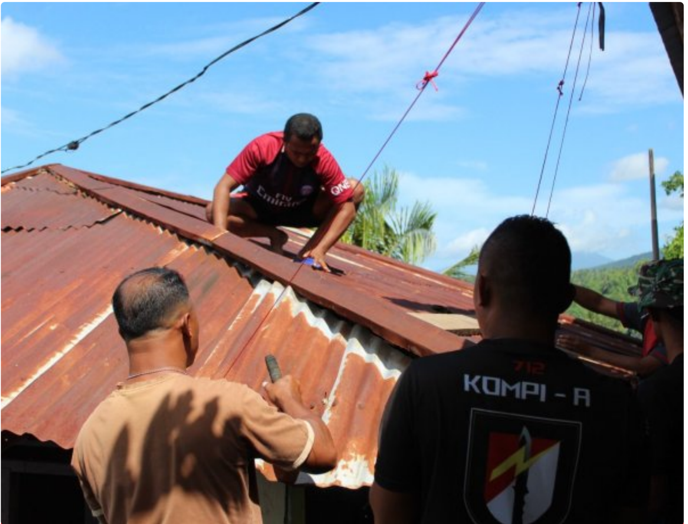
Pembongkaran Bangunan Rumah lama, Keluarga Gavin Karaki Pemema Bantuan. RTLH TMMMD Ke 116 Kodimn 1310 Bitung
