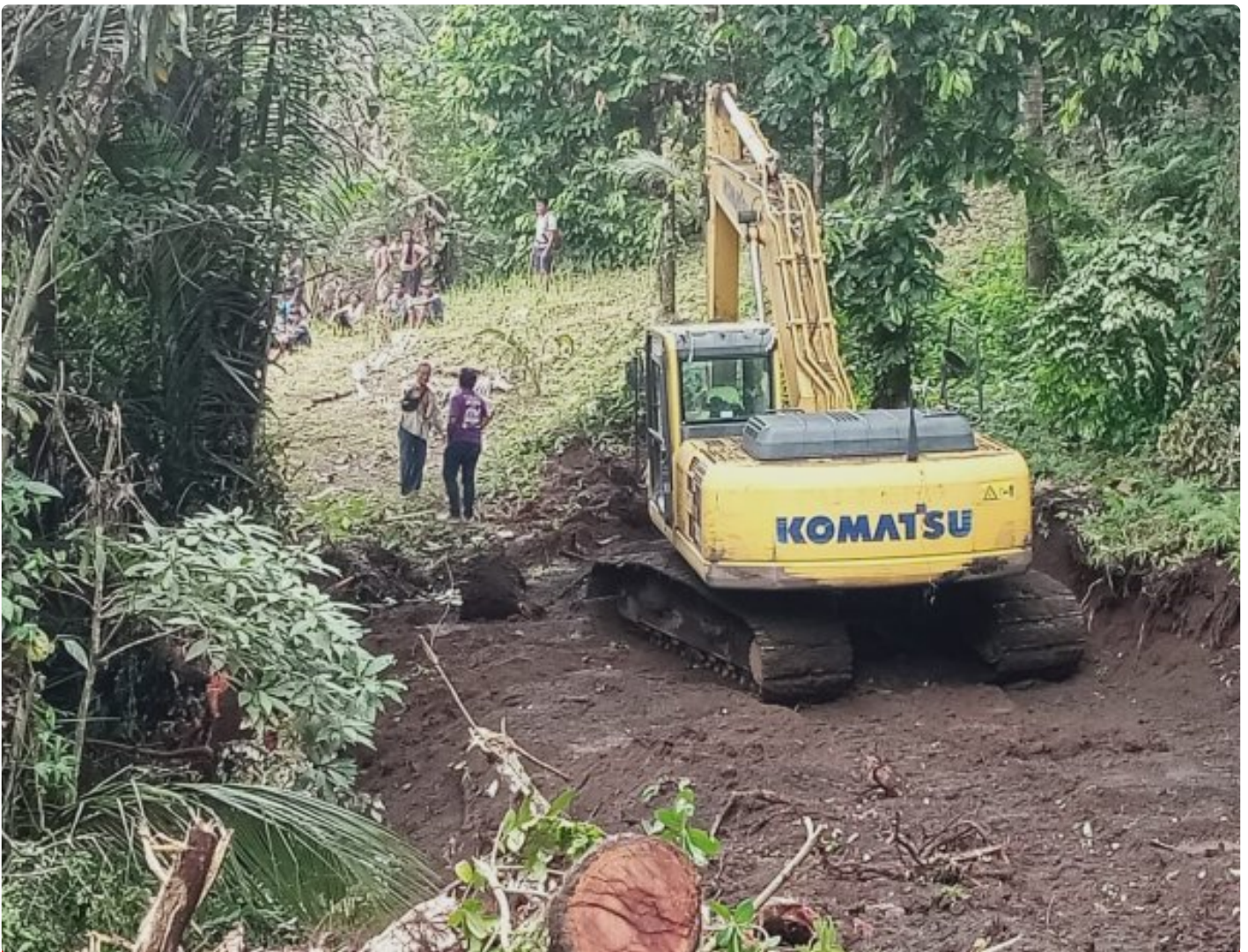
Lokasi Pekerjaan Perintisan Jalan TMMD Ke-116 Kodim 1310 Bitung di Kelurahan Tandurusa
