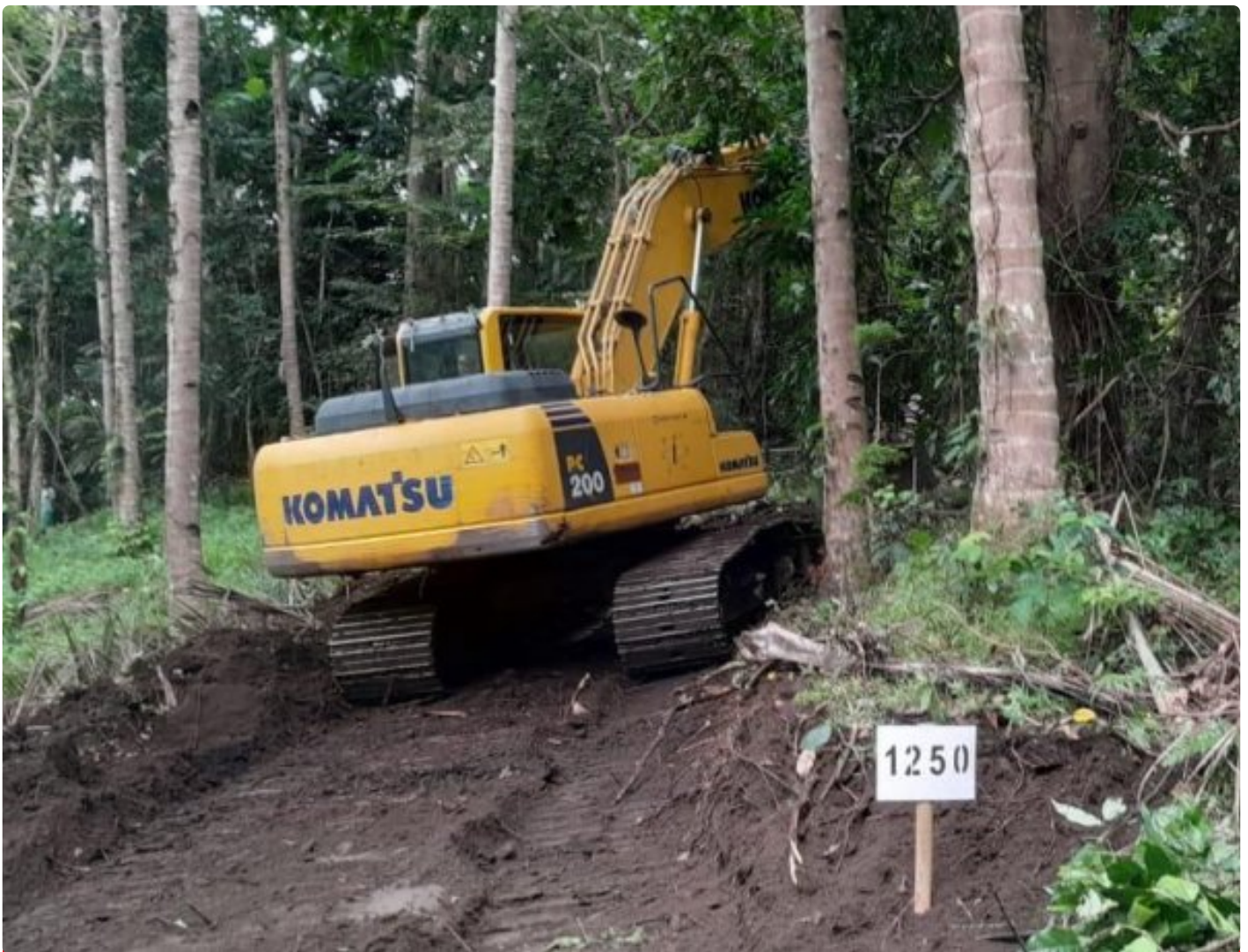
Pekerjaan Pembukaan Jalan Pertanian Oleh Satgas TMMD Ke-116 Kodim 1310 Bitung
